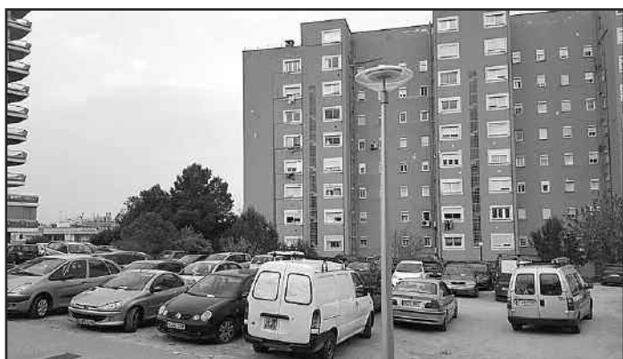
Vista parcial del solar en cuestión.
